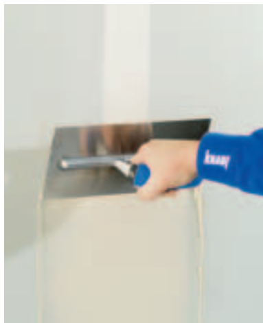
Als zweiter Arbeitsgang folgt die Verarbeitung mit der gebogenen Traufel
